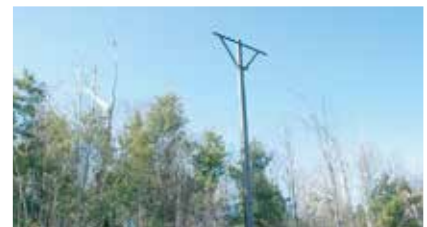
新たな監視木の設置
